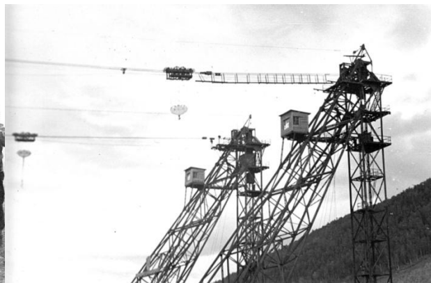
Кабель-краны на строительстве ГЭС.
