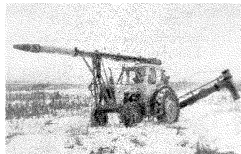
Телескопический трубопровод готов к выходу в поле.
