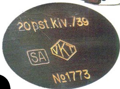
На левой стороне ствольной коробки нанесена маркировка – официальное наименование, завод-изготовитель и серийный номер
